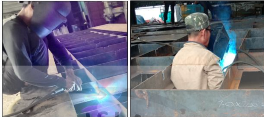
Gambar 4.2 Proses Pengelasan Bagian Gritting
