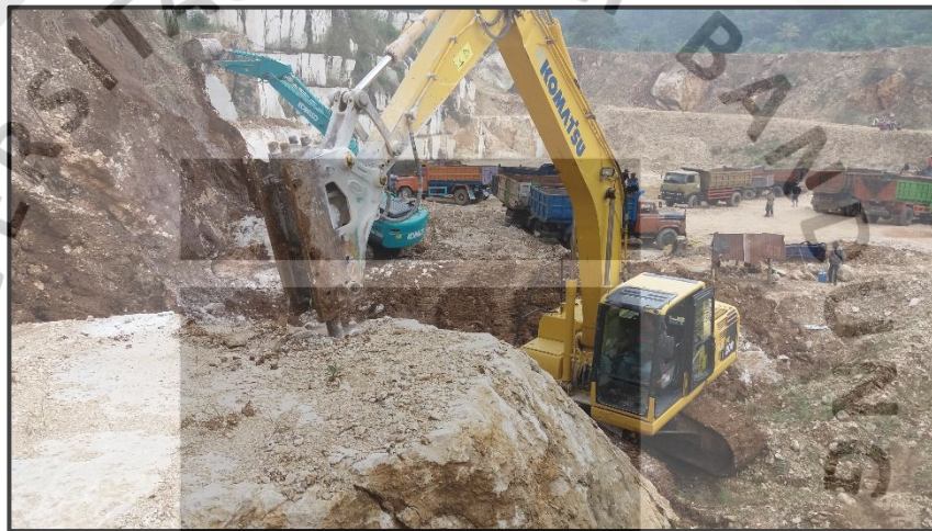
Gambar 2.2 Proses Penggalian Menggunakan Breaker
