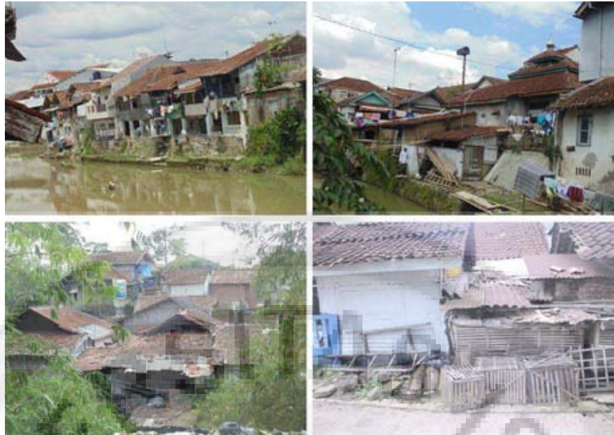
Gambar 1.5 Kondisi Fisik Bangunan Sumber : Hasil Observasi, 2015
