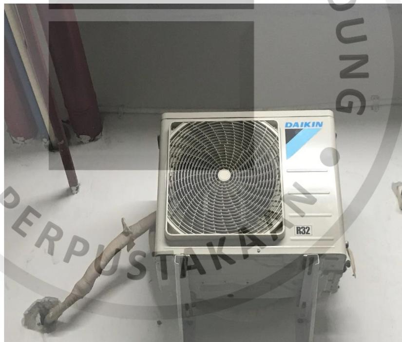
AC yang digunakan oleh DeBraga Artotel menggunakan freon R32. Yaitu Freon yang paling ramah lingkungan dibandingkan Freon R22.
