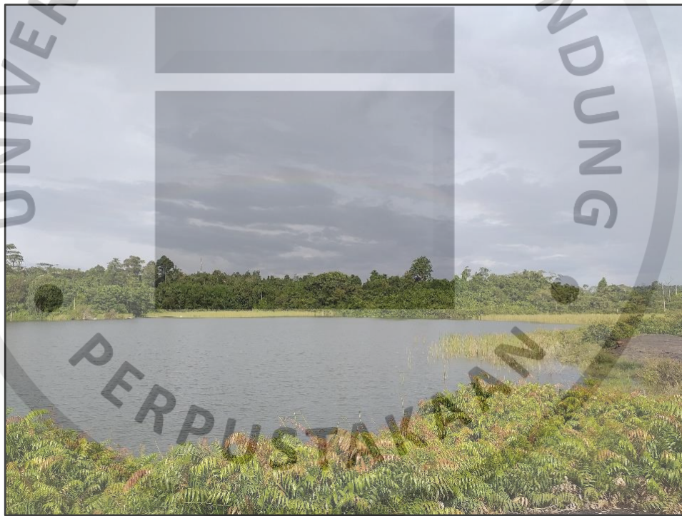
Gambar 2.6 Kondisi Tailing Dam Pada Tahun 2018
