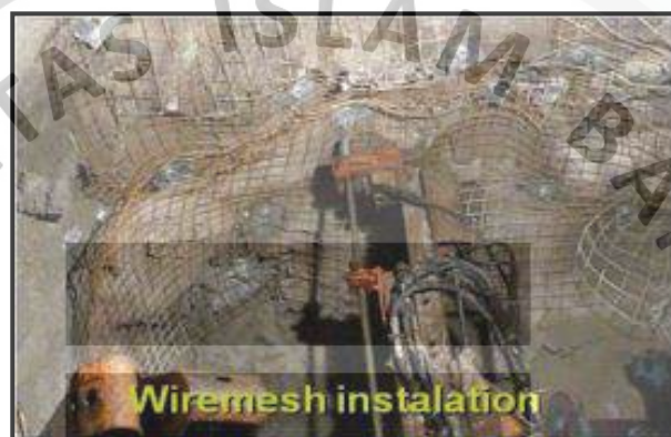
Gambar 2.12 Pemasangan wiremesh
