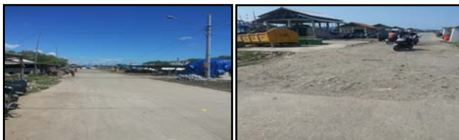
Gambar 4.5 Kondisi Jalan yang Terdapat di TPI Karangsong
