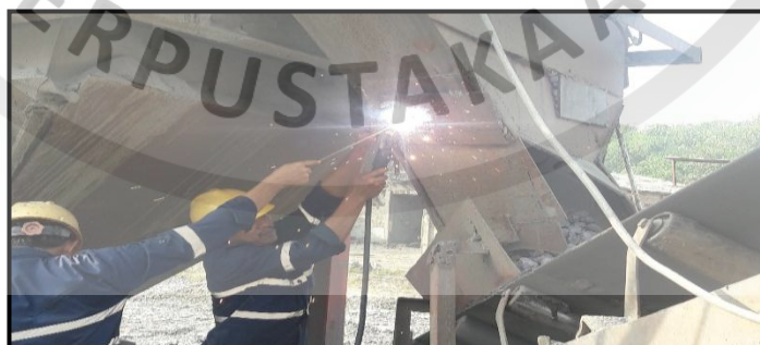
Gambar 5.5 Foto Kegiatan Pengelasan Corong
