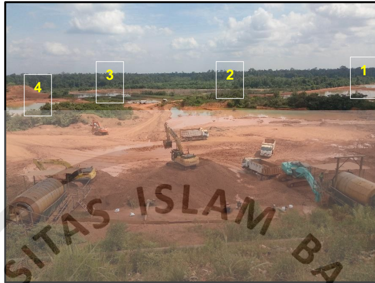
Gambar 4. 11 Lokasi Tailing Pond
