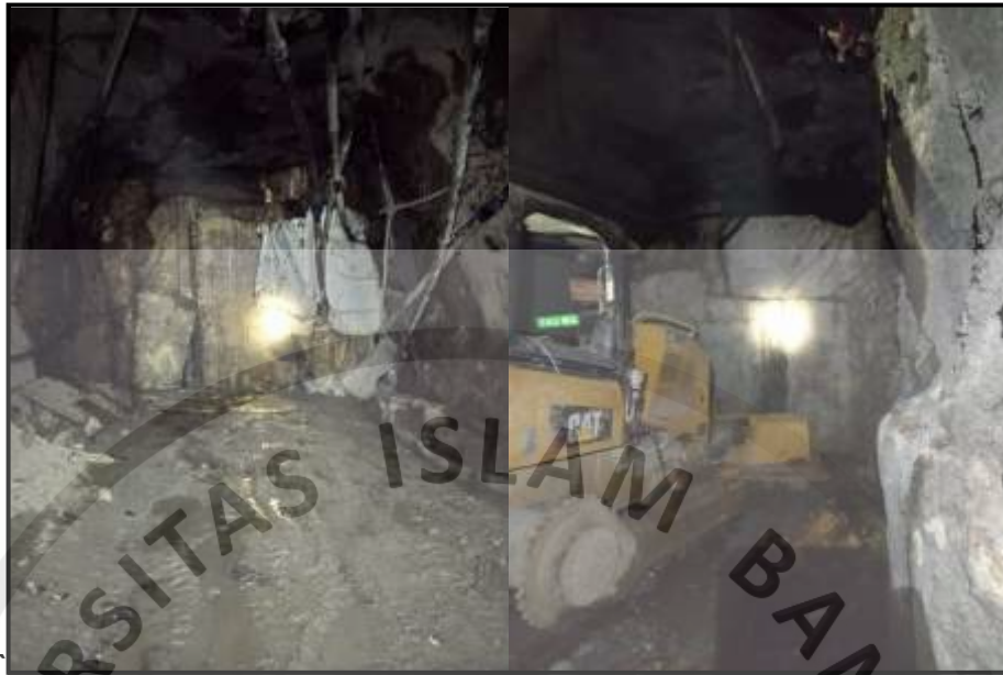
Gambar 4.5 Kondisi Pintu Angin Yang Tidak Tertutup Sempurna
