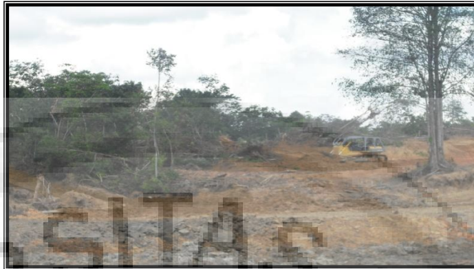
Foto 2.1 Kegiatan Pengupasan Tanah Penutup
