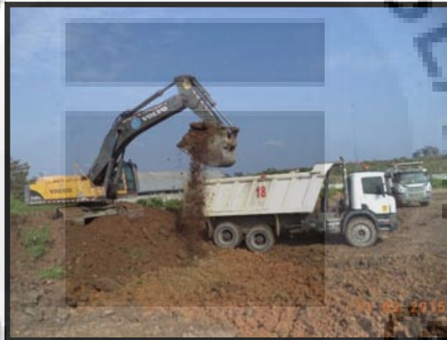
Gambar 2.7 Foto Pengupasan Top Soil
