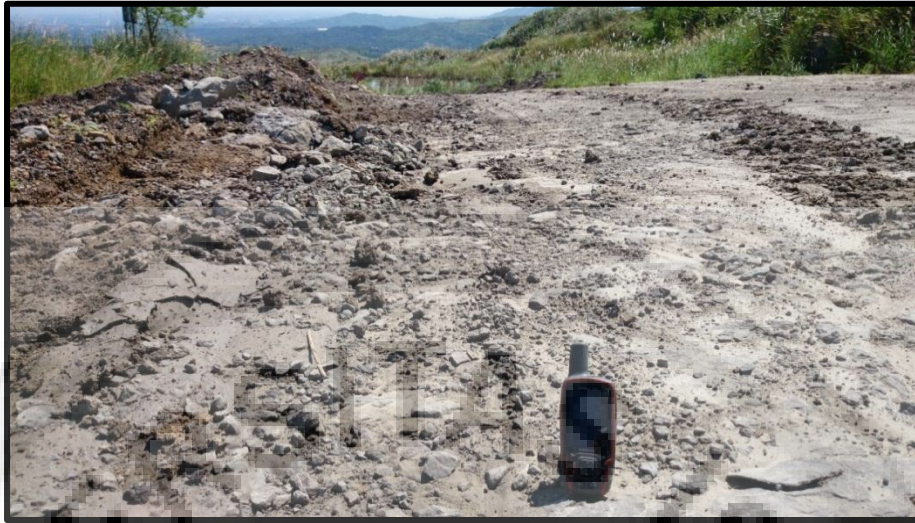
Sumber : pengamatan lapangan, 2014 Foto 4. 4 Kondisi Hauling Road Segmen 6
